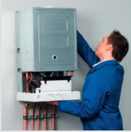
2 Cihazın asılması ve bağlantıların montajı
