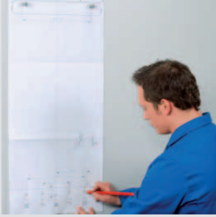
1 Montaj şablonu yardımıyla işaretleme
